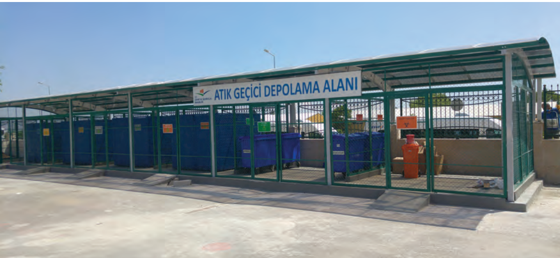
Atık Geçici Depolama Alanı
